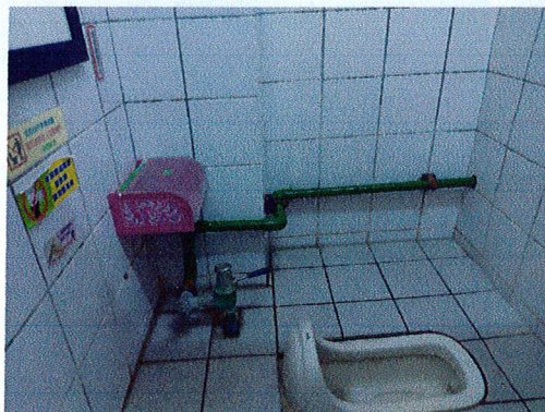
說明：利用所收集到的雨水來進行沖洗廁所，及馬桶用水。
