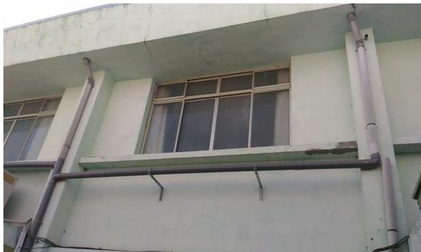
說明：天溝集水槽水管路線改造
