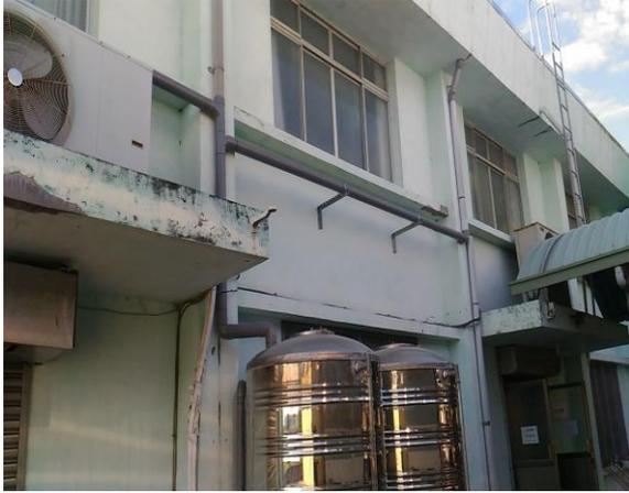
說明：天溝集水槽水管路線改造
