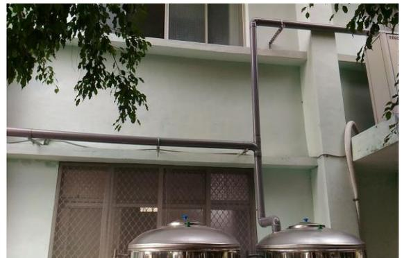
說明：天溝集水槽水管路線改造
