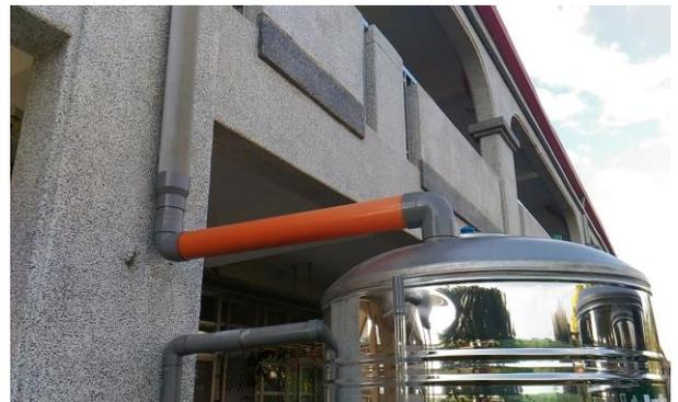
說明：天溝集水槽水管路線改造
