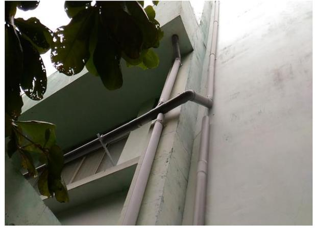
說明：天溝集水槽水管路線改造
