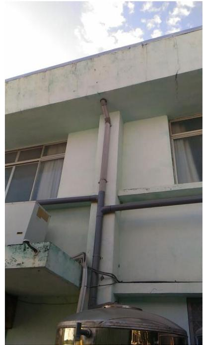
說明：天溝集水槽水管路線改造
