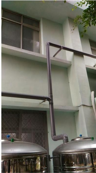
說明：天溝集水槽水管路線改造
