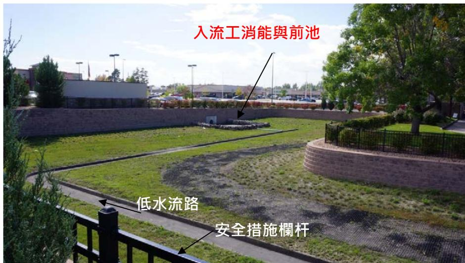
照片 5-6 滯洪設施入流工前池周遭安全設施與低水流路
