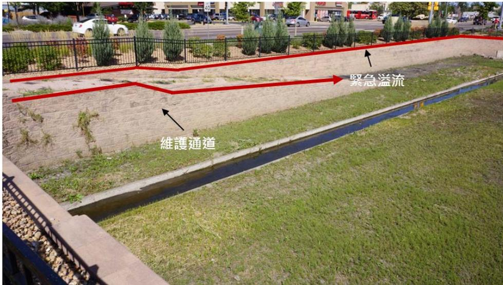
照片 5-7 滯洪設施為維護通道及降低堤岸高程為緊急溢流
