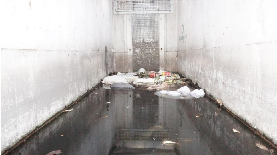
照片 5-9(B) 出流工之微前池之雜物與出流工攔污柵設施
