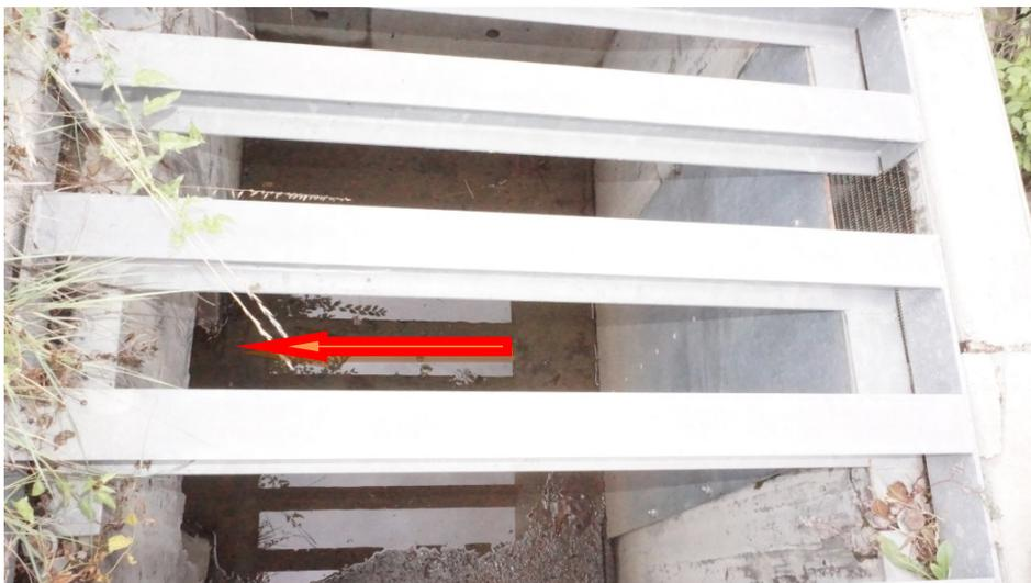
照片 5-11 豎井式出流工與聯外排水路箱涵連結情形
