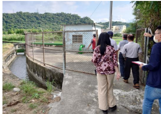
(f)七公圳 1 號井設施及環境維護說明
