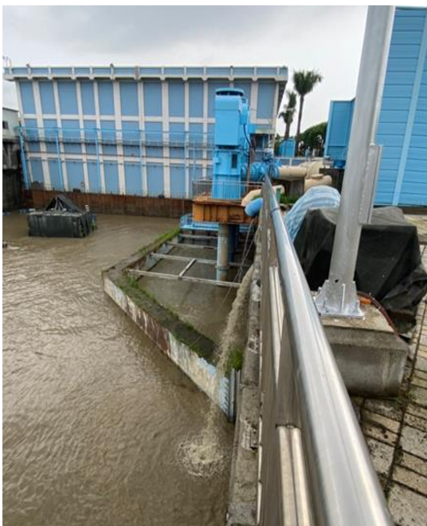
照片 22 南區水資源局抗旱水井功能測試現場照片
