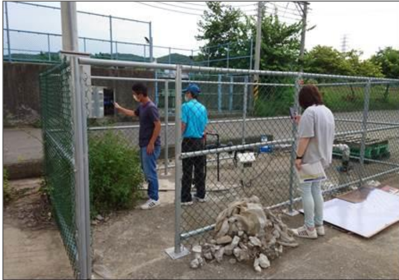
照片 2 新埔淨水場抗旱水井功能測試現場照片
