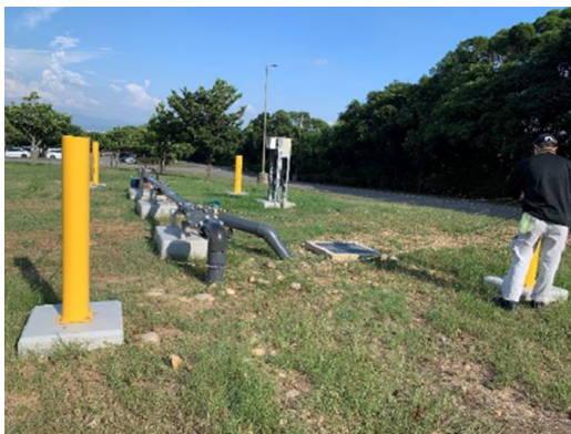
(a)13/13 抗旱水井設施及環境維護
