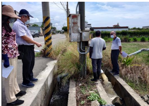
(a)大潭 14 號井抽水測試情形
