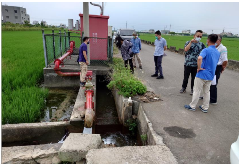
照片 17 農水署雲管處斗南鎮抗旱水井功能測試現場照片
