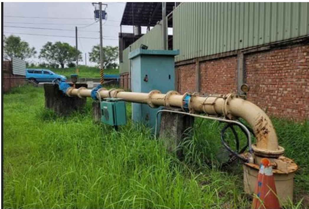
照片 23 台水公司第七區管理處抗旱水井功能測試現場照片
