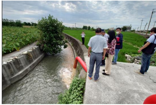
(c)日南 13 號井測試抽水
