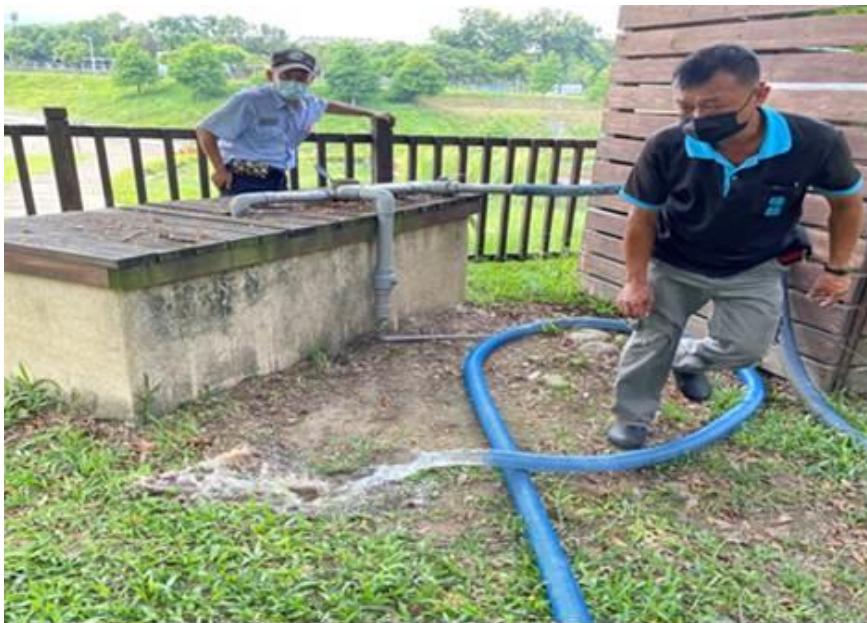
照片 20 台中市坪林森林公園抗旱水井功能測試現場照片
