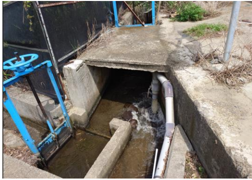
(c)大潭 17 號井抽水測試情形
