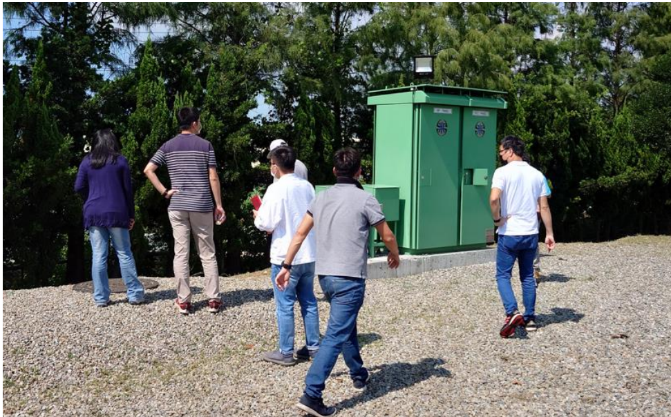
照片 12 自來水公司十一區處抗旱水井功能測試現場照片
