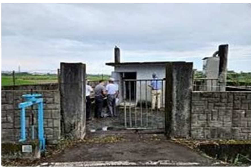
照片 30 農水署花蓮管理處抗旱水井測試現場照片
