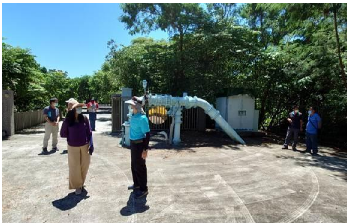
照片 29 台水公司第十區管理處抗旱水井測試現場照片
