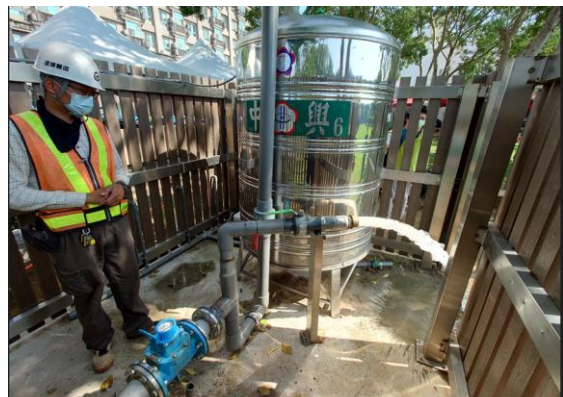
(b)抗旱水井測試抽水
