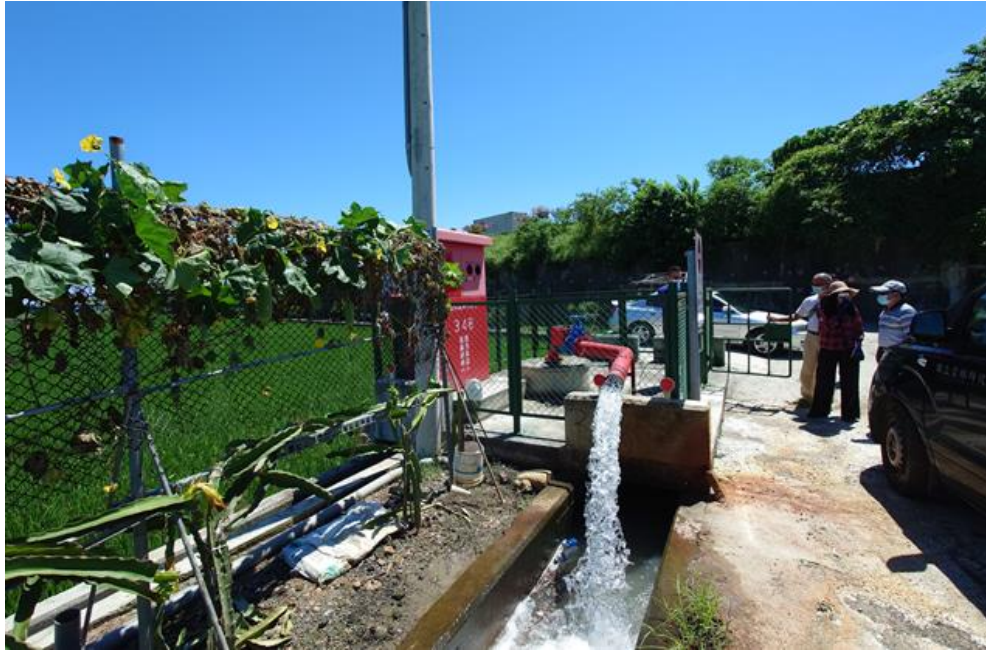
照片 19 農水署雲管處大埤鄉抗旱水井功能測試現場照片
