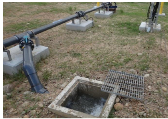
(b)13/13 抗旱水井測試抽水
