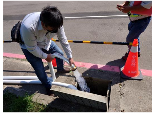
(b) 園區抗旱水井測試抽水
