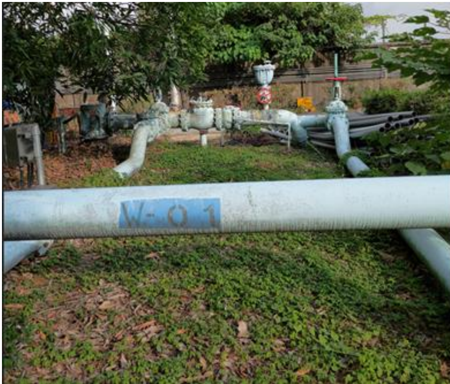
照片 26 中油公司高雄分部抗旱水井測試現場照片
