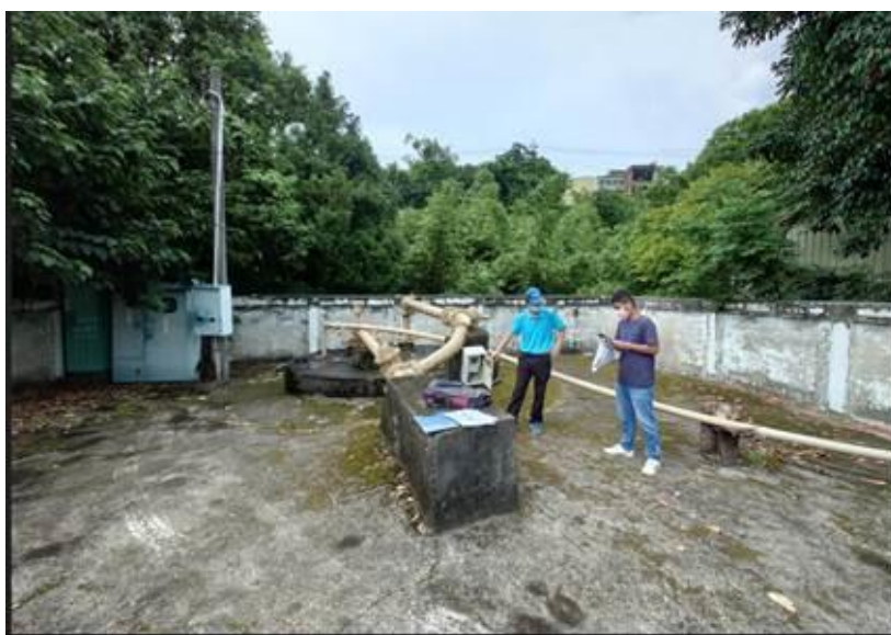
照片 1 芎林淨水場抗旱水井功能測試現場照片
