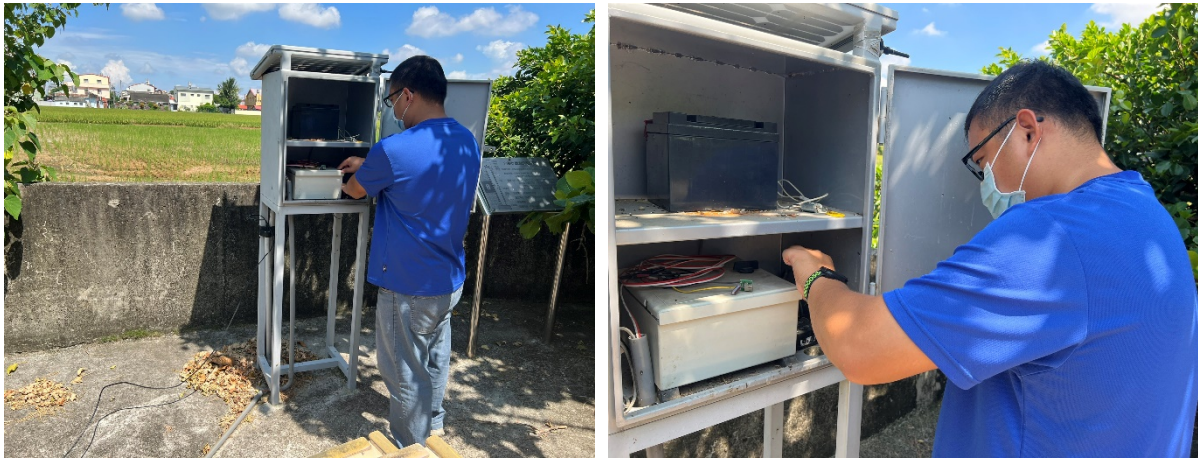
灣內國小深層水準樁設備維護(含儀器箱、樁位保護台清潔)
