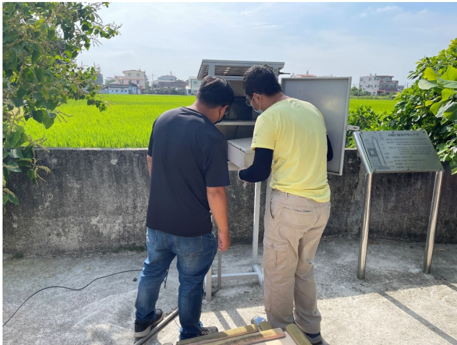
灣內國小深層水準樁設備維護 1
