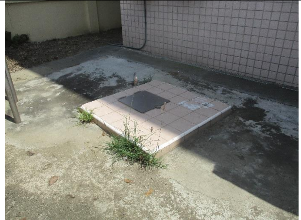
維護後現場景況
