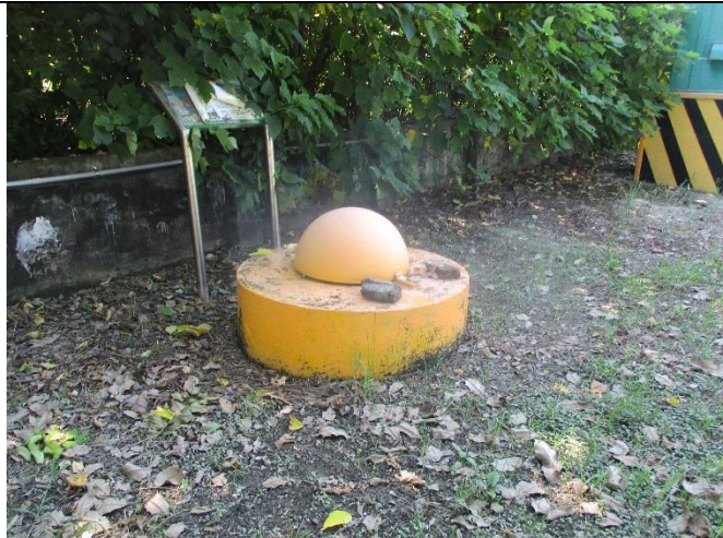
維護前現場景況
