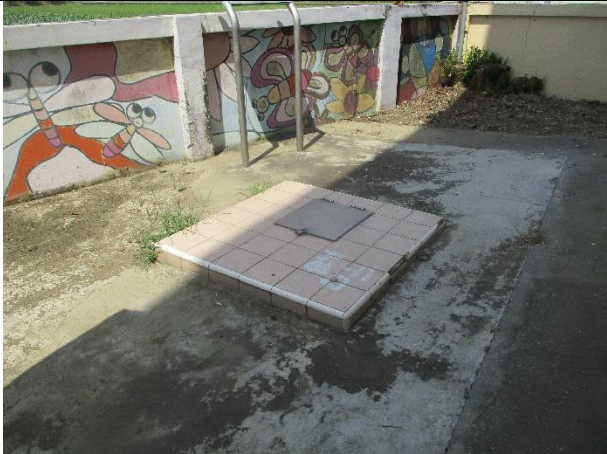
維護前現場景況
