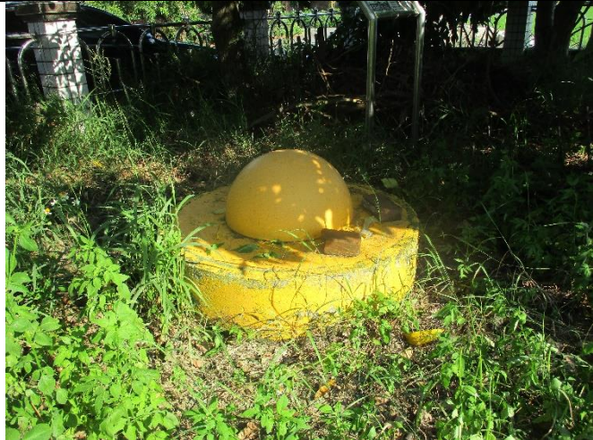
維護前現場景況
