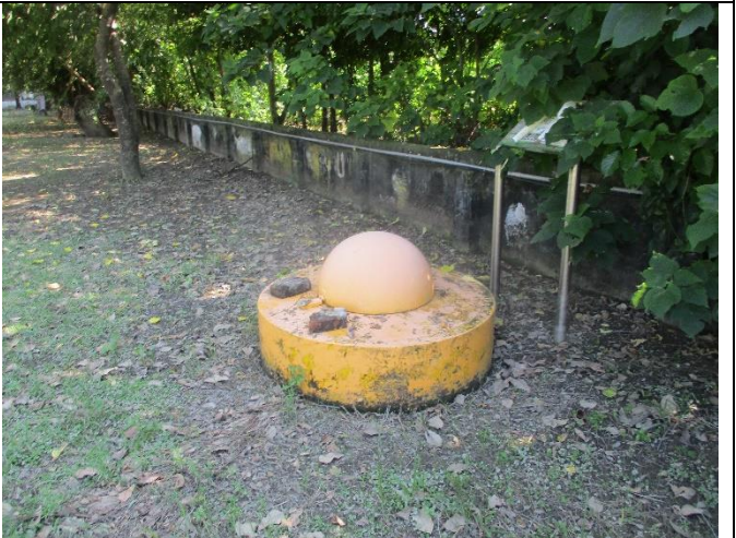
維護後現場景況
