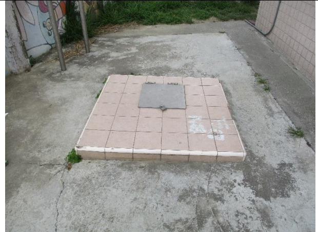
維護後現場景況
