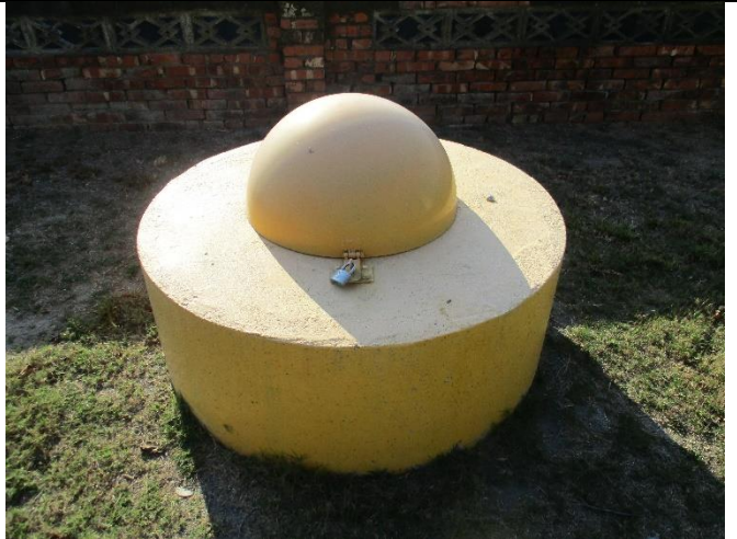
維護後現場景況
