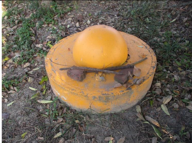
維護前現場景況
