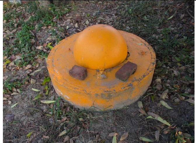
維護後現場景況
