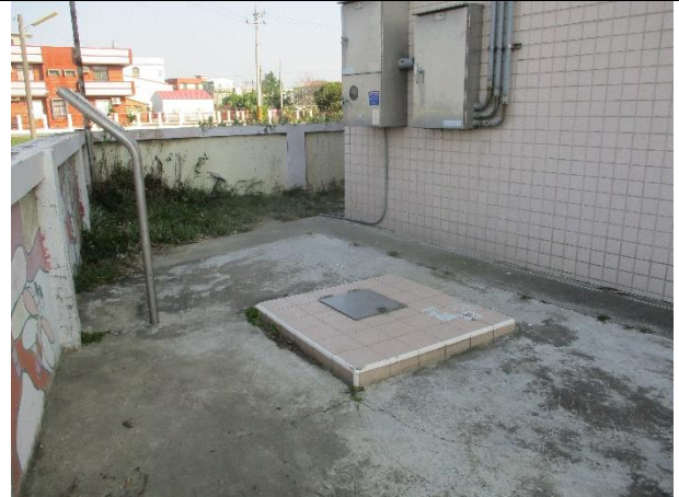
維護後現場景況
