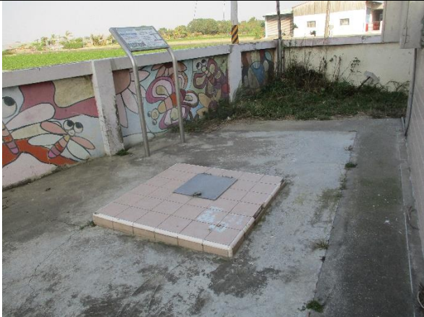
維護前現場景況
