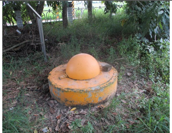
維護後現場景況
