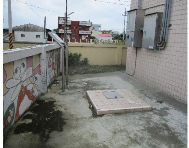
維護後現場景況
