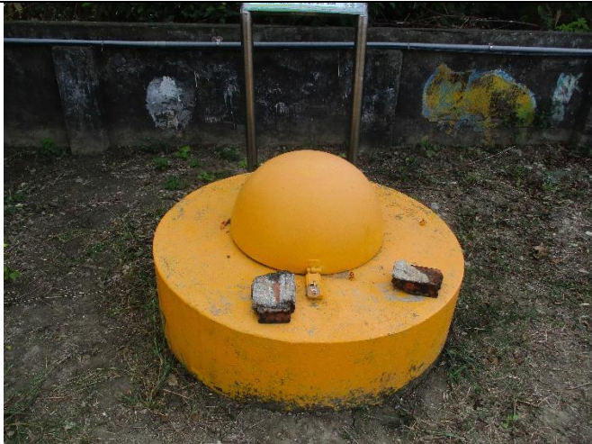
維護前現場景況
