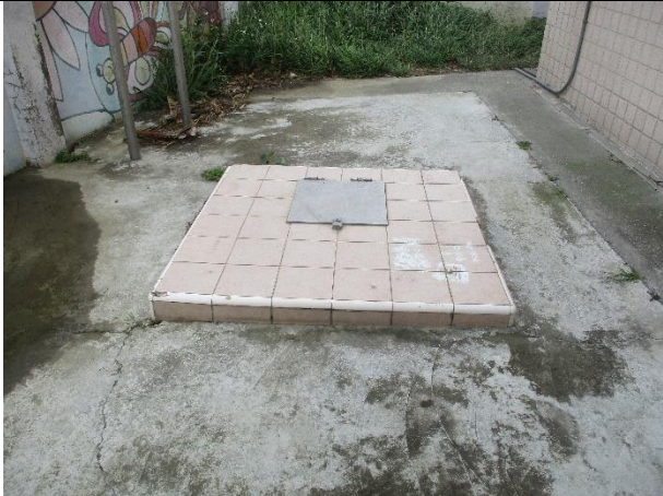
維護前現場景況
