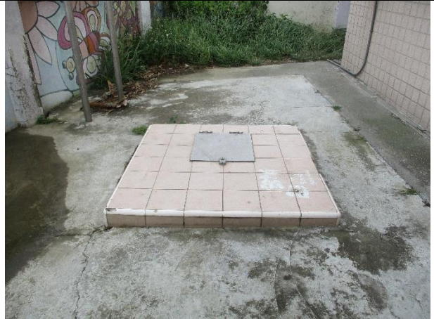
維護後現場景況
