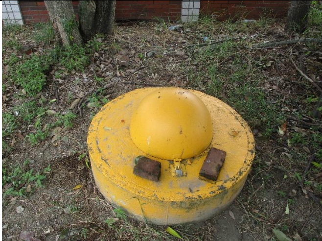
維護前現場景況
