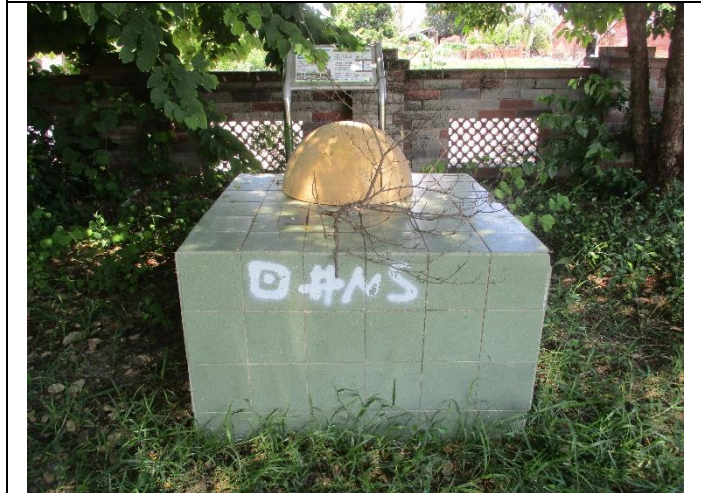
維護前現場景況
