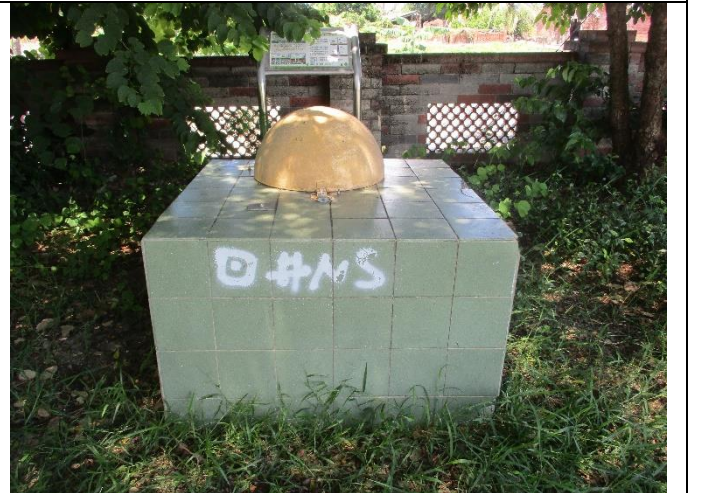
維護後現場景況
