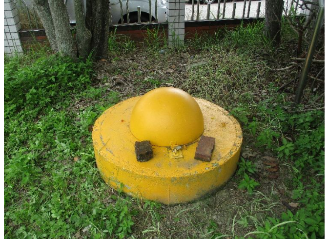
維護後現場景況
