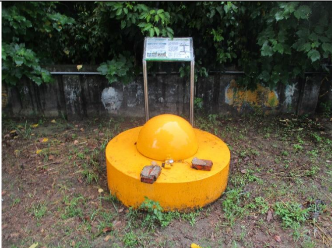
維護前現場景況
