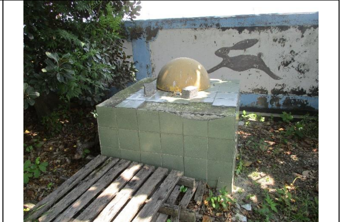
維護後現場景況
