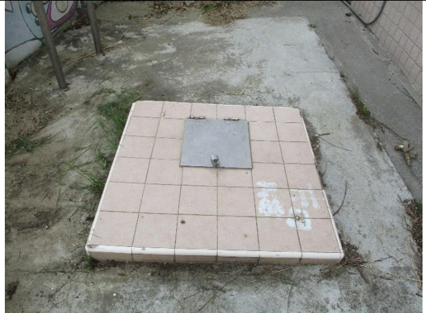
維護後現場景況
