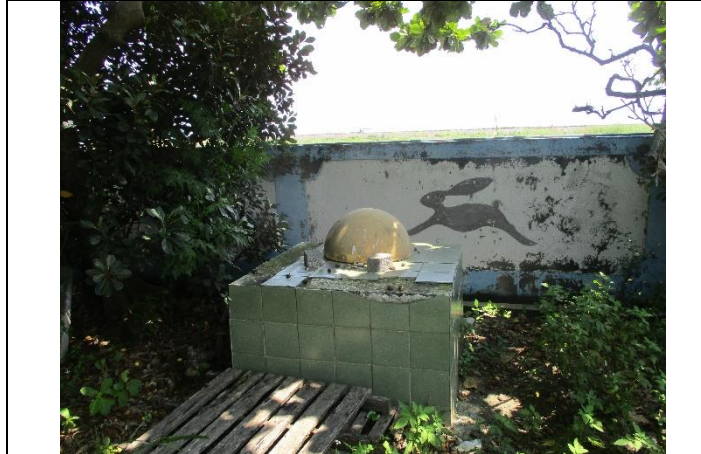
維護前現場景況
