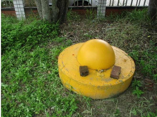
維護前現場景況
