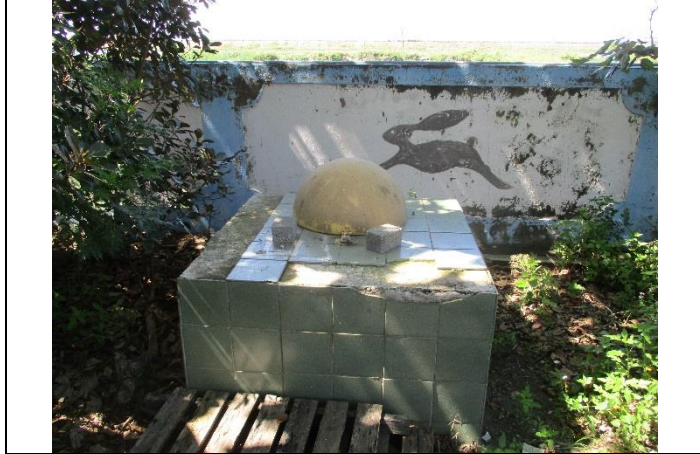
維護前現場景況
