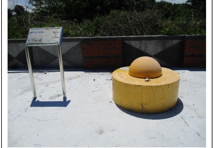
維護後現場景況
