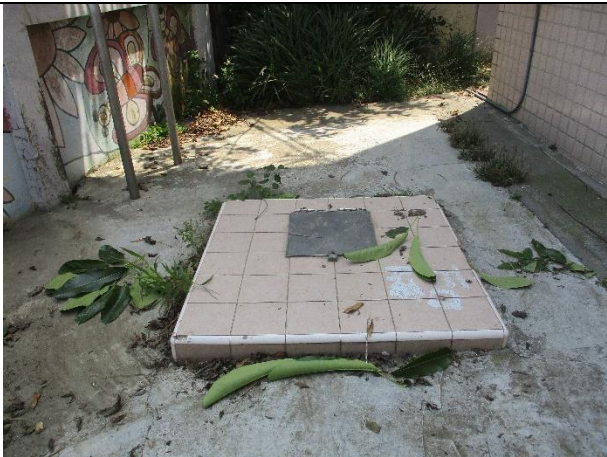
維護前現場景況
