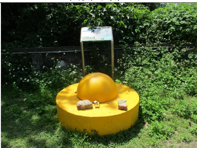
維護前現場景況
