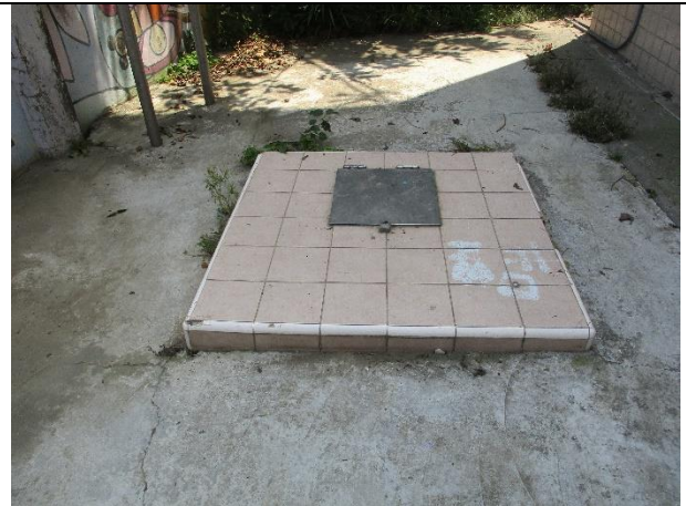
維護後現場景況
