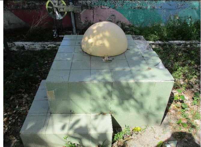
維護前現場景況
