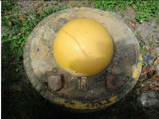
維護前現場景況
