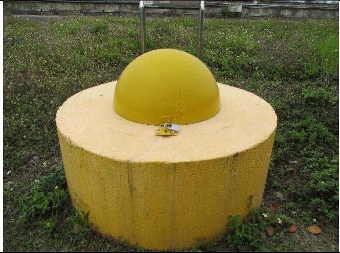
維護前現場景況
