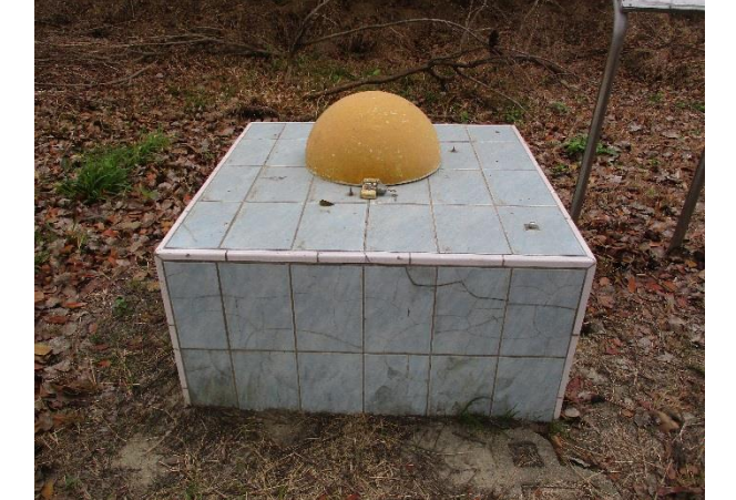
維護前現場景況
