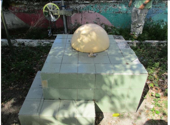
維護後現場景況
