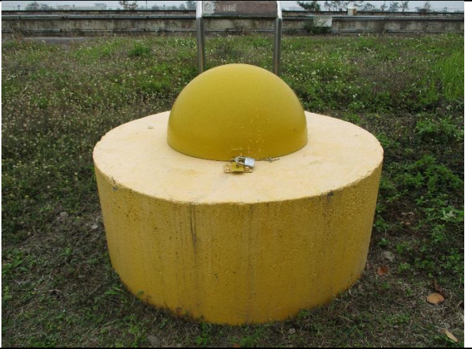
維護後現場景況
