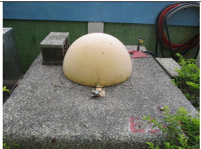
維護前現場景況
