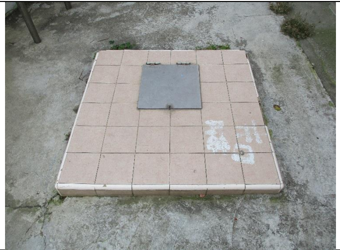
維護後現場景況
