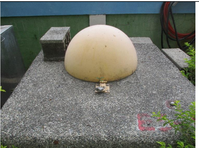
維護後現場景況
