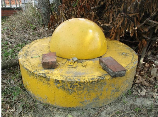
維護前現場景況
