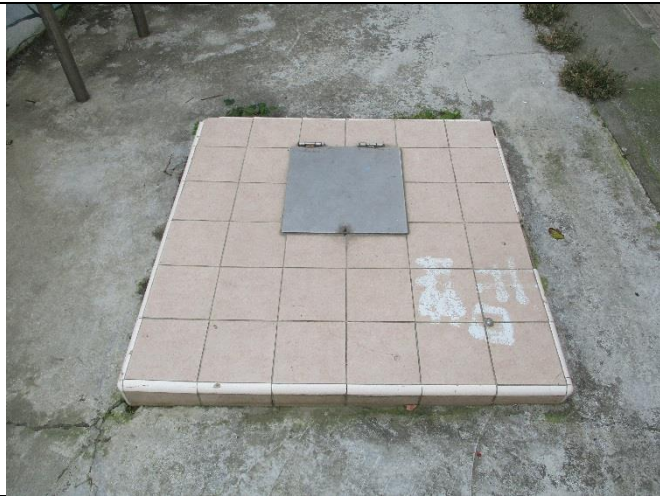
維護前現場景況
