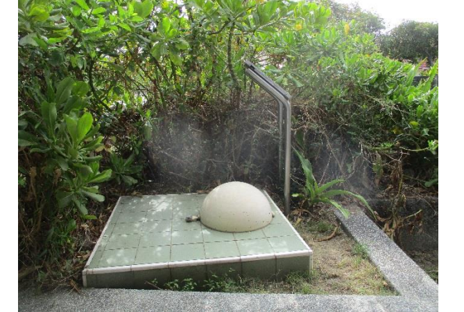
維護後現場景況
