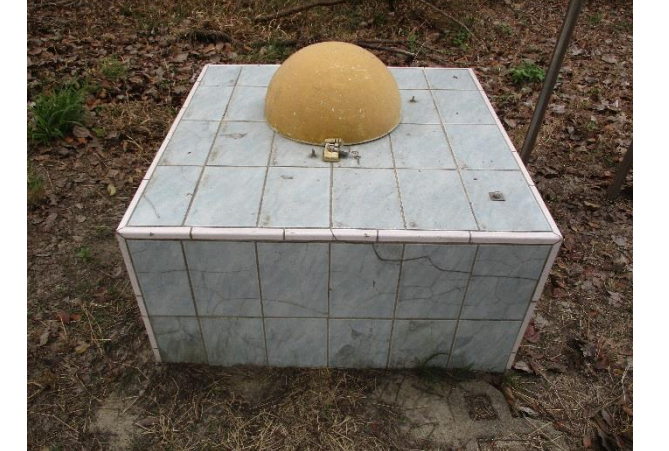
維護後現場景況
