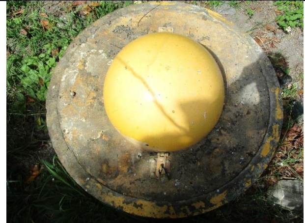
維護後現場景況
