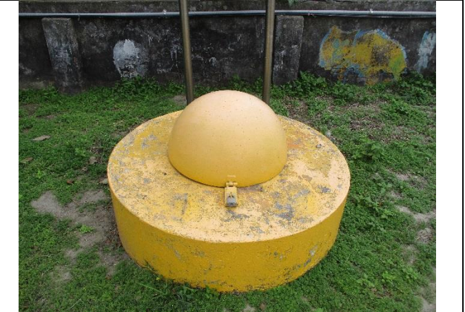
維護後現場景況
