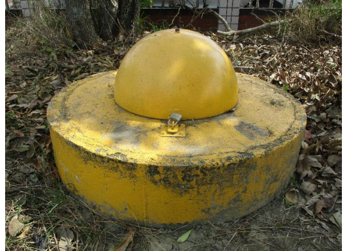
維護後現場景況
