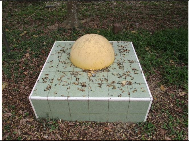
維護前現場景況
