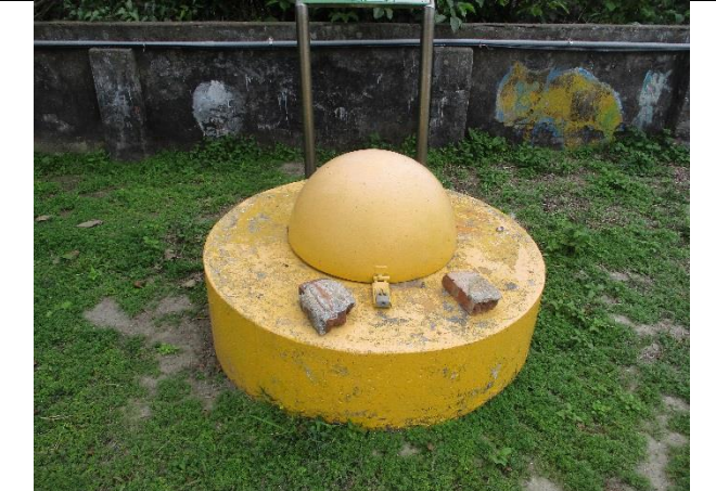
維護前現場景況
