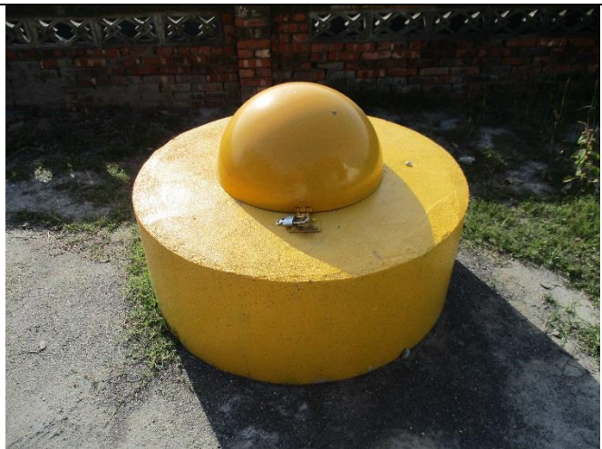
維護前現場景況
