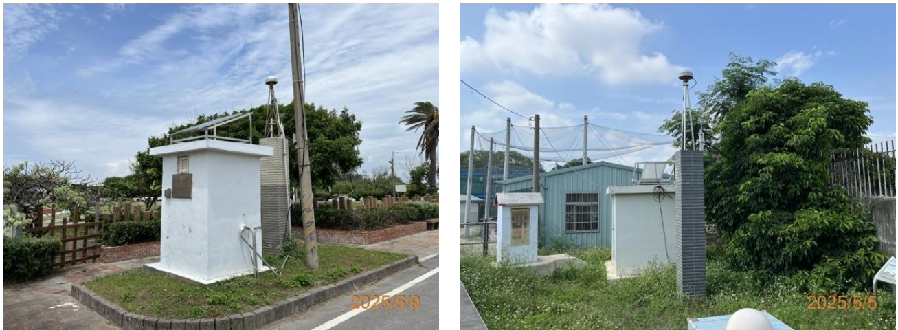
圖9 彰化西港國小(左)與雲林客厝國小(右)GNSS 天線柱現況
