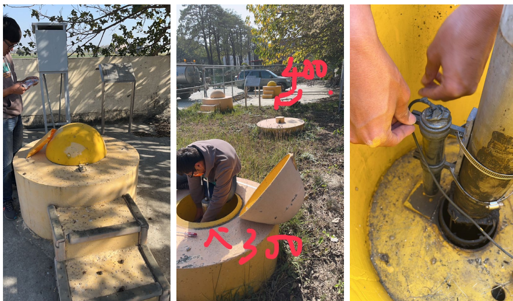
圖 7 深層水準樁探針調整工作照
