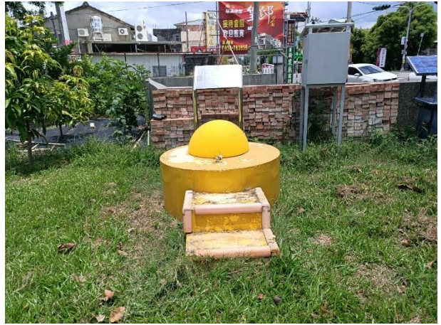
維護後現場景況
